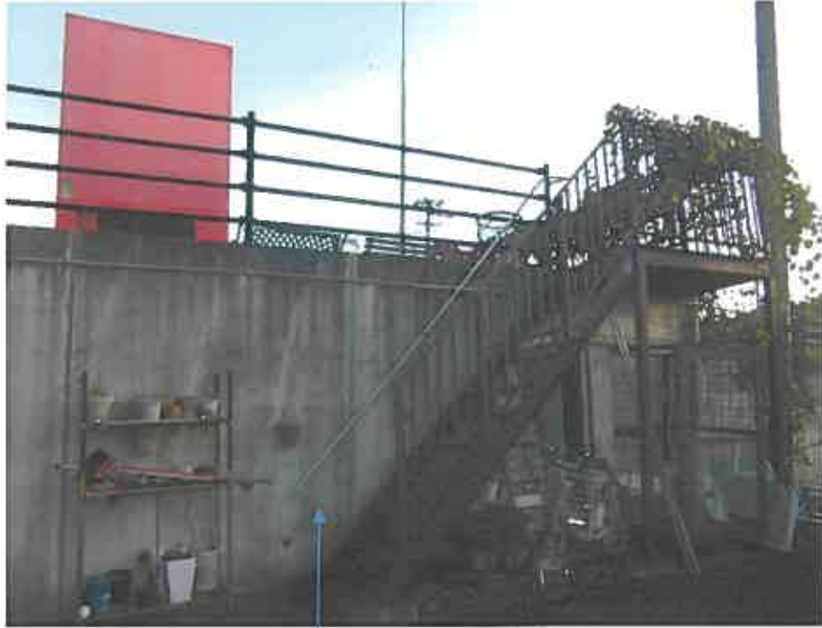
擁壁・階段(構築物)及び階段
