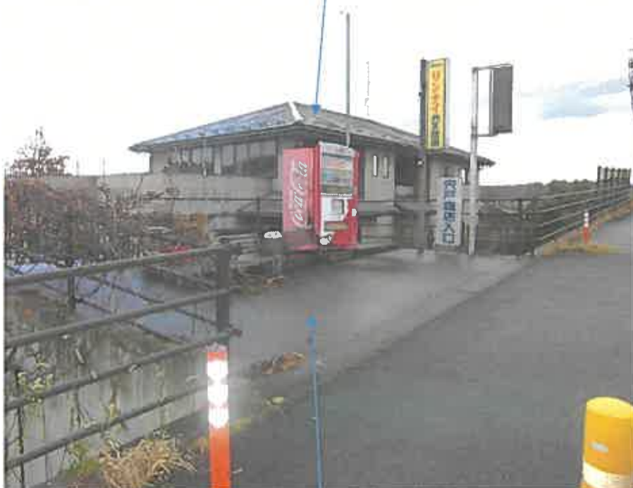
擁壁・階段(構築物)
