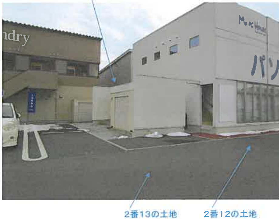
写真④ 家屋番号2番12の建物の付帯設備(ガス庫、空調室外機等)
