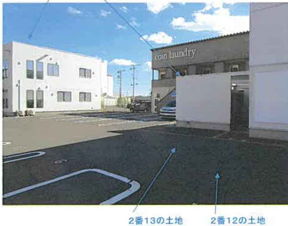
写真③ 物件2 家屋番号2番12の建物の付帯設備(ガス庫、空調室外機等)
