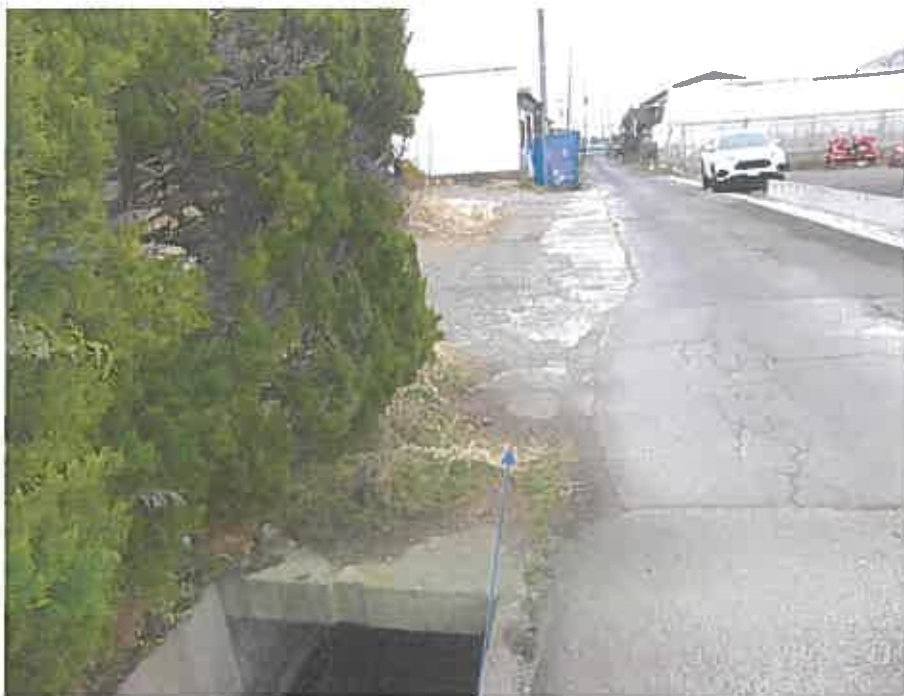
水路上に設置されているコンクリート製の構築物
