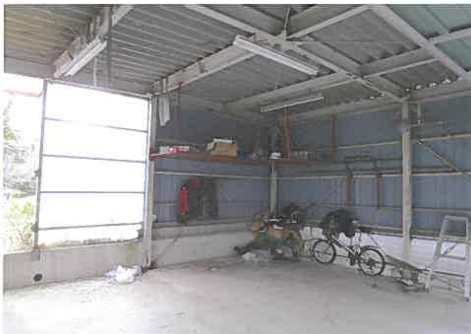
写真③ 車庫の内部の状況
