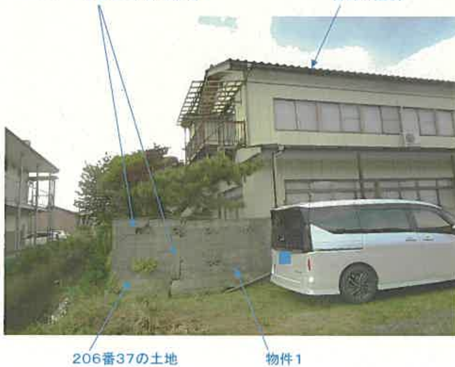
写真② コンクリート塀の損傷
