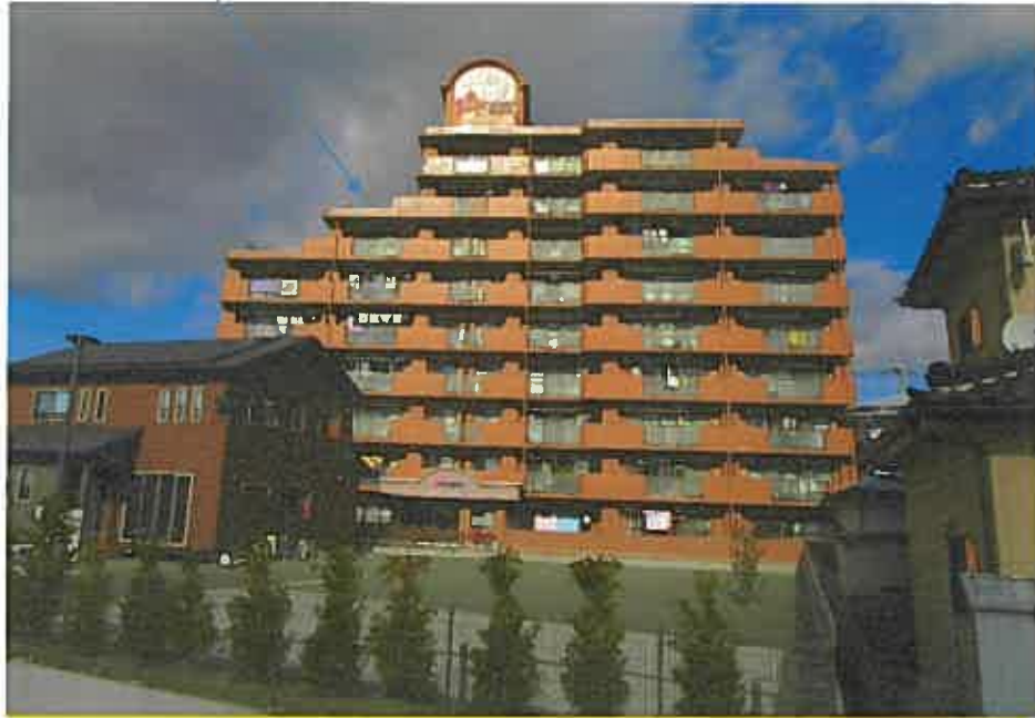
写真① 物件1の存する1棟の建物
