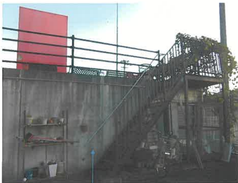
擁壁・階段(構築物)及び階段
