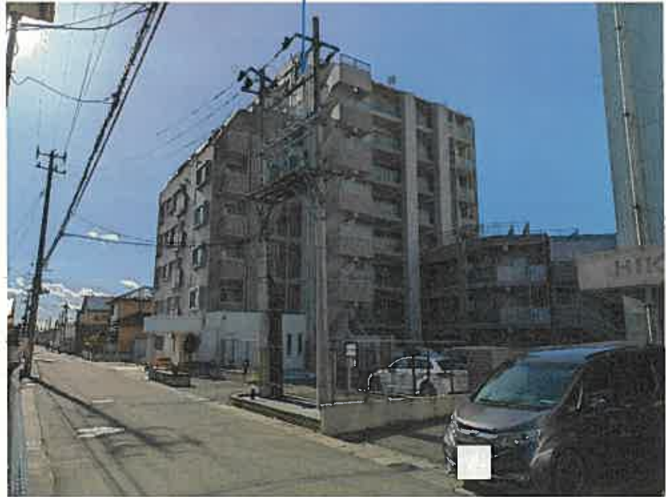
写 真 1 物件1の存する一棟の建物
