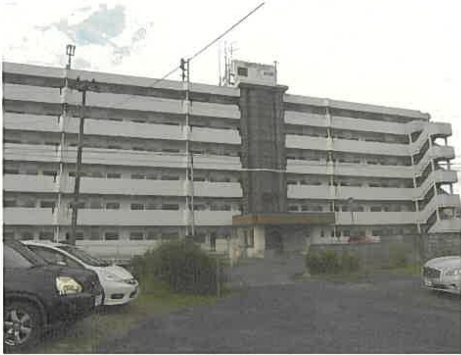
写真 1 本件物件が所在する1棟の建物
