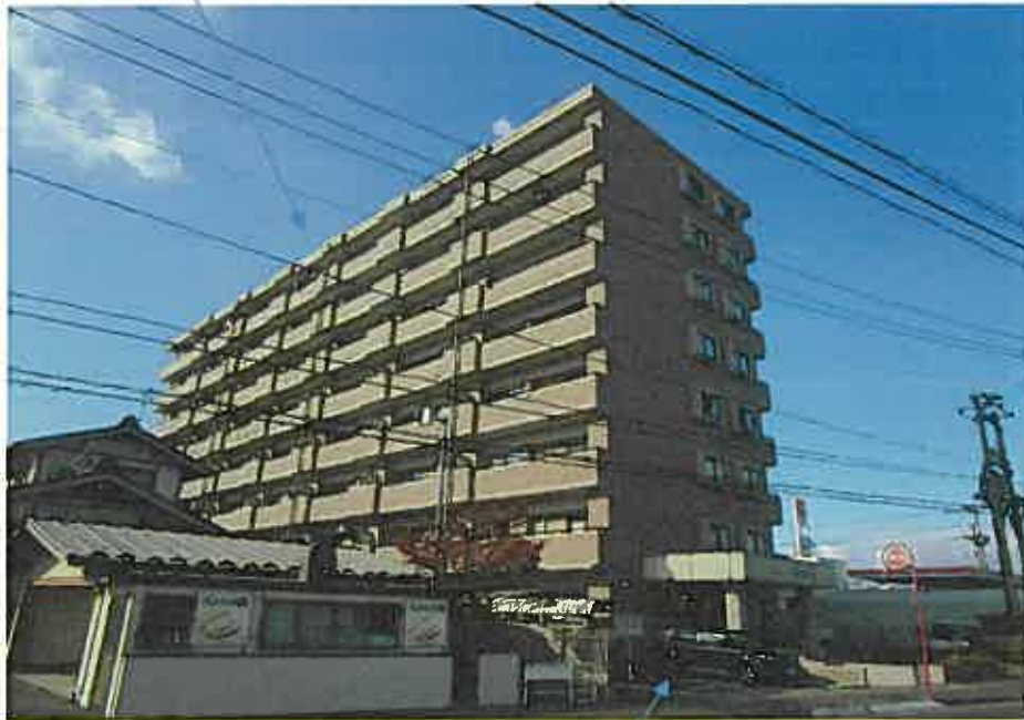
写真① 物件1の存する1棟の建物
