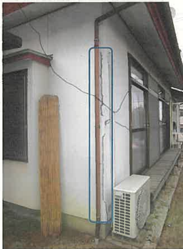
写真 8 外壁のひび割れを補修した状況
