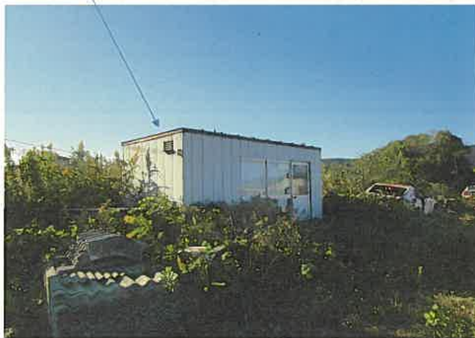
写真⑥ 軽量鉄骨製物置(動産)
