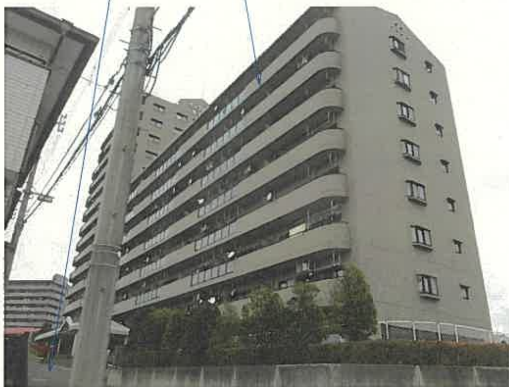
写 真 1 市道 一棟の建物
