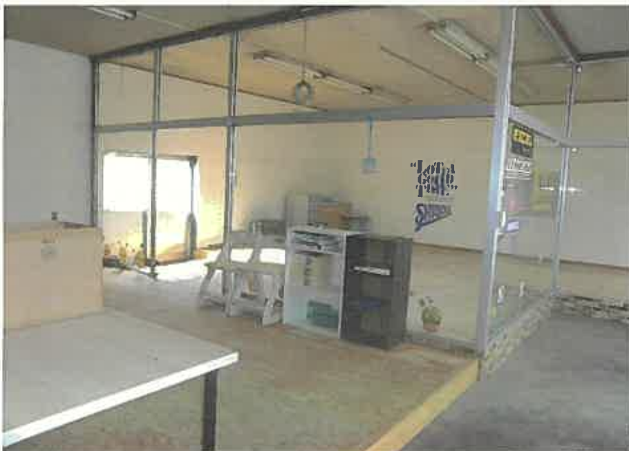
写真 6 以下物件3の内部状況
