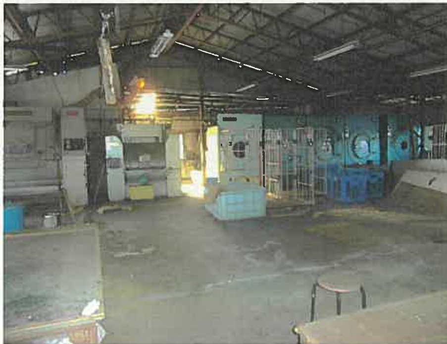
写真 10 物件4の内部状況
