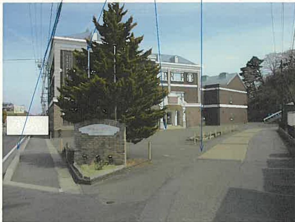
写真 1 国道 物件10 物件1～7 道路
