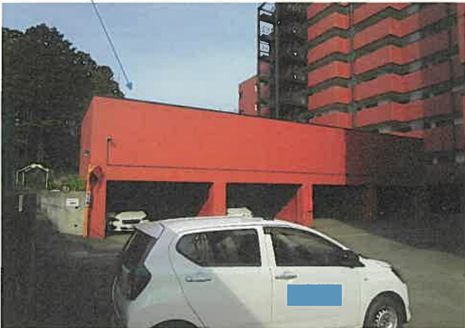
写真⑥ 物件2の存する1棟の建物
