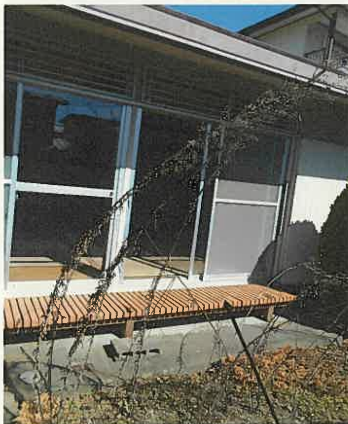
板間付き和室・床の間付き和室南側の状況
