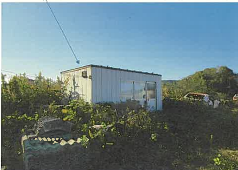
写真⑥ 軽量鉄骨製物置(動産)
