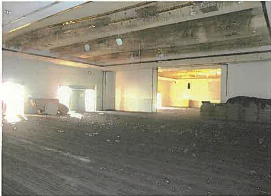
写真 29 天井に吊されたガラス飾りが床に散乱している状況
