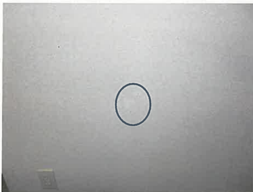
内壁の小穴を補修した状況
