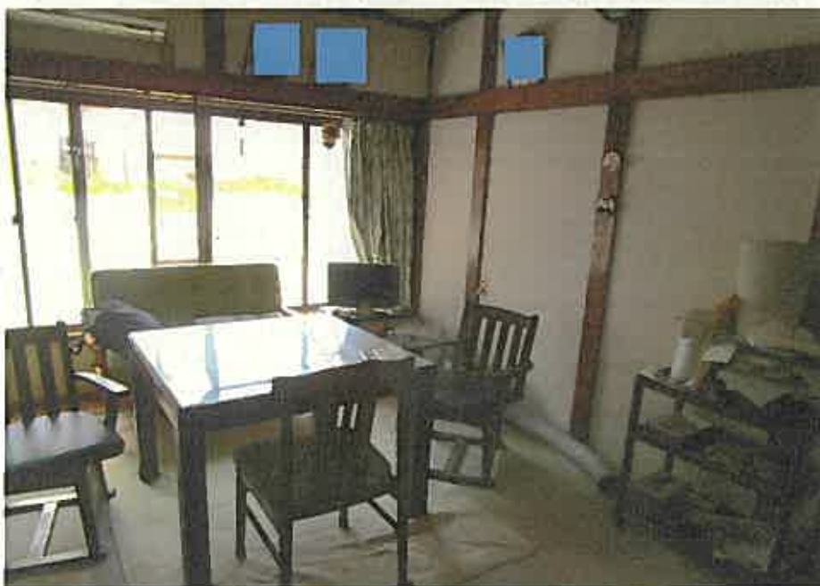
写真⑧ 以下、物件2の内部の状況
