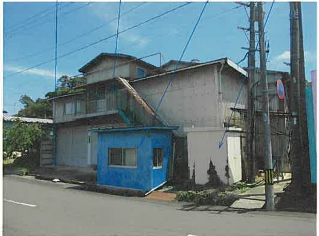
写真 1 物件 1 物件 2 主である建物 物件 2 附属建物符号 1 変電設備
