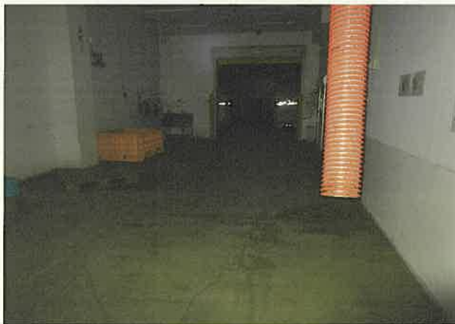
写真④ 以下、⑪まで物件2(主である建物)の内部の状況
