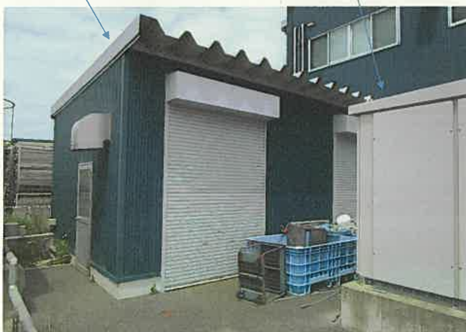
写真② 物件2(附属建物符号1) 変電設備
