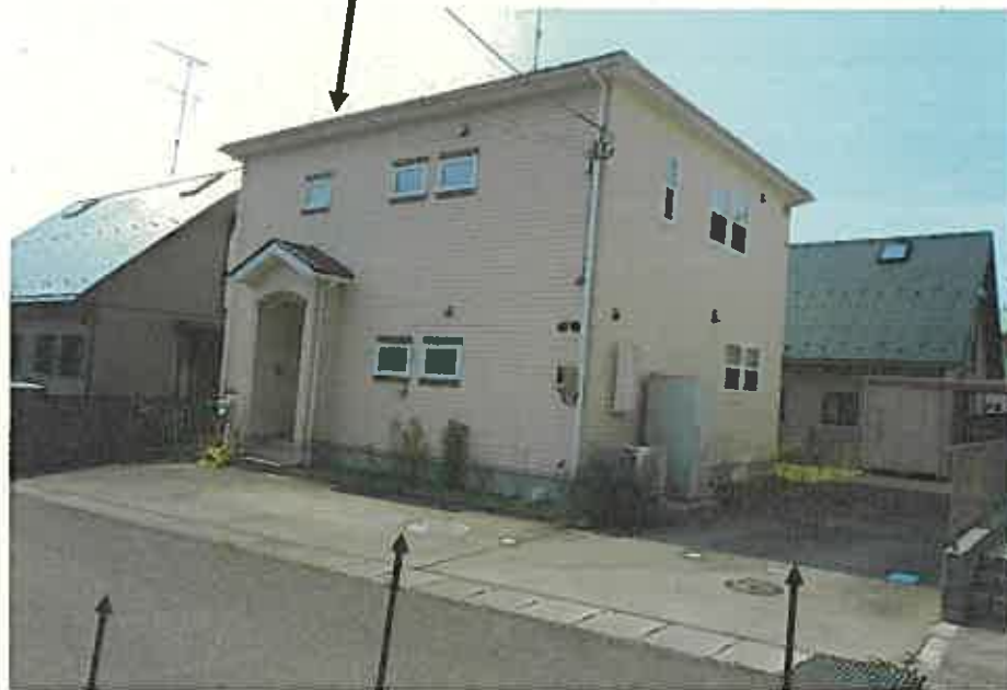
岩沼市道 「北長谷堤上西線」 浄化槽
