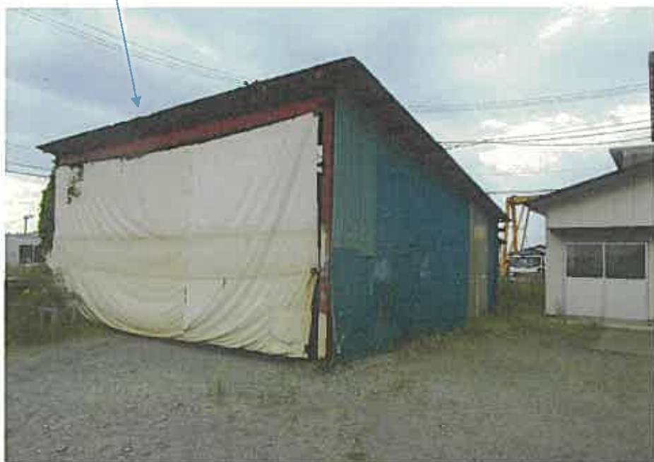
写真④ 物件2(未登記附属建物)
