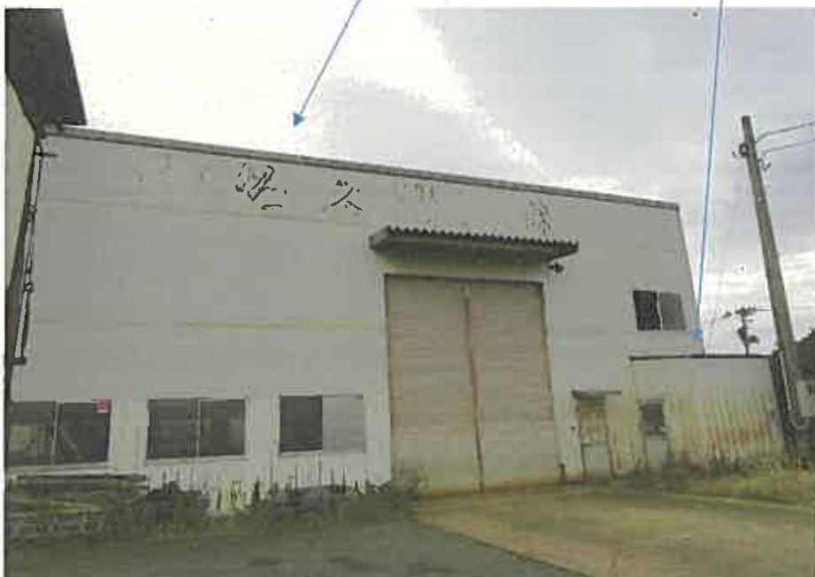
写真② 物件2(主である建物) 増築部分
