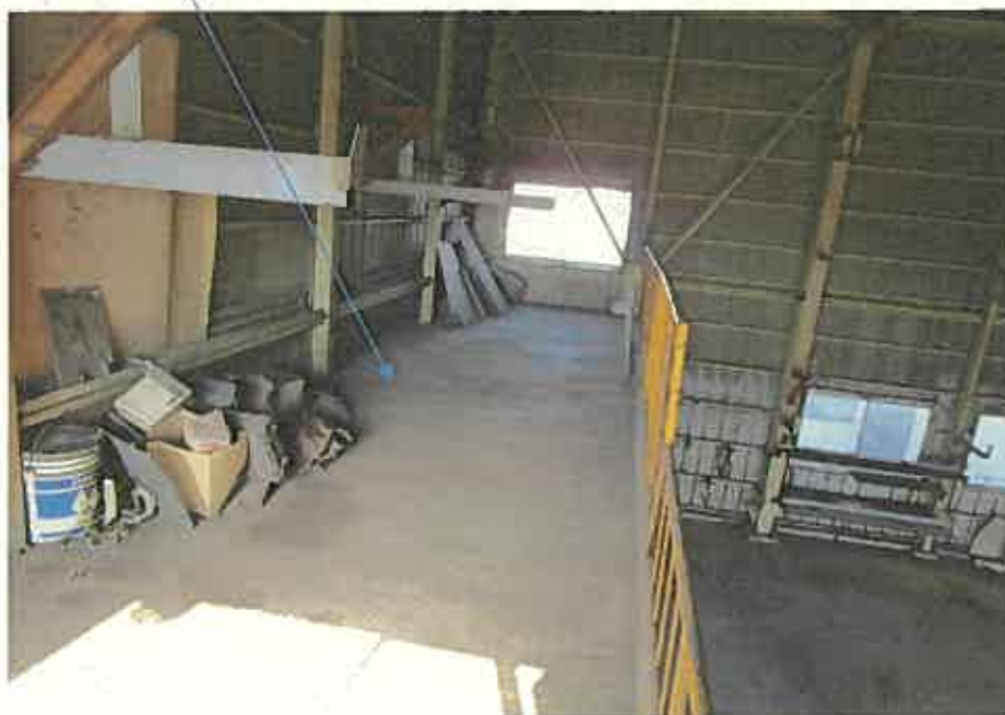
写真⑦ 2階増築部分
