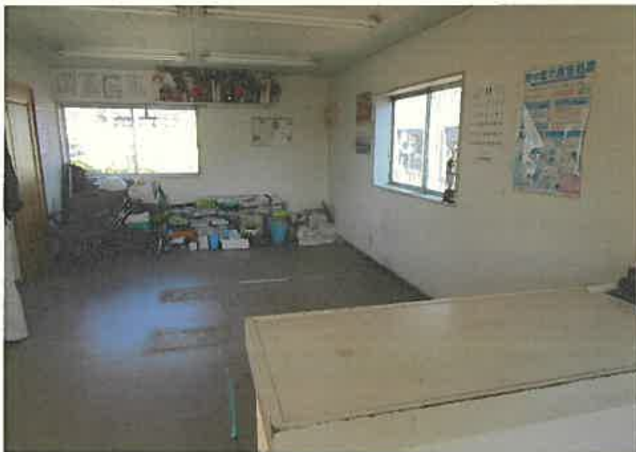
写真⑨ 以下、⑫まで物件2(附属建物符号1)の内部の状況
