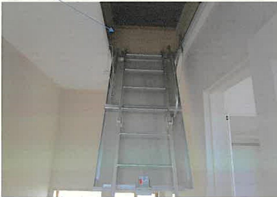
写真⑧ 小屋裏収納口
