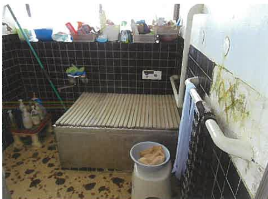
物件2:1階浴室の状況
