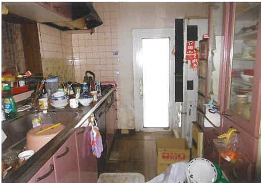
物件4:1階台所の状況
