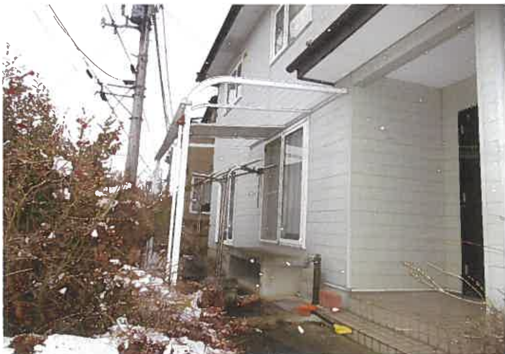
物件4:下屋の状況
