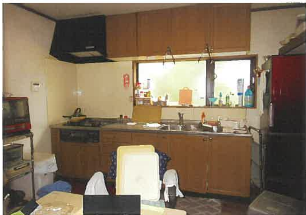
物件3: 1階台所の状況
