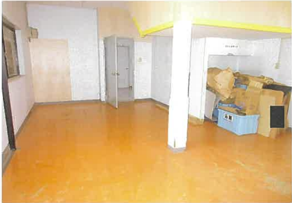
物件2主である建物:1階倉庫の状況
