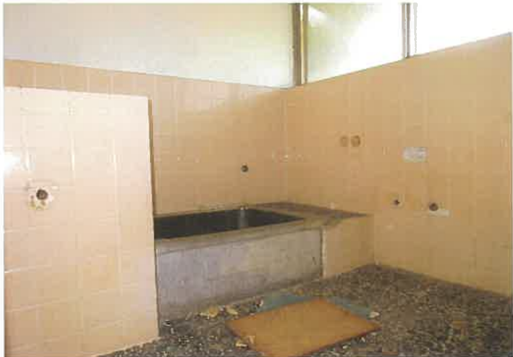
物件7:1階浴室の状況
