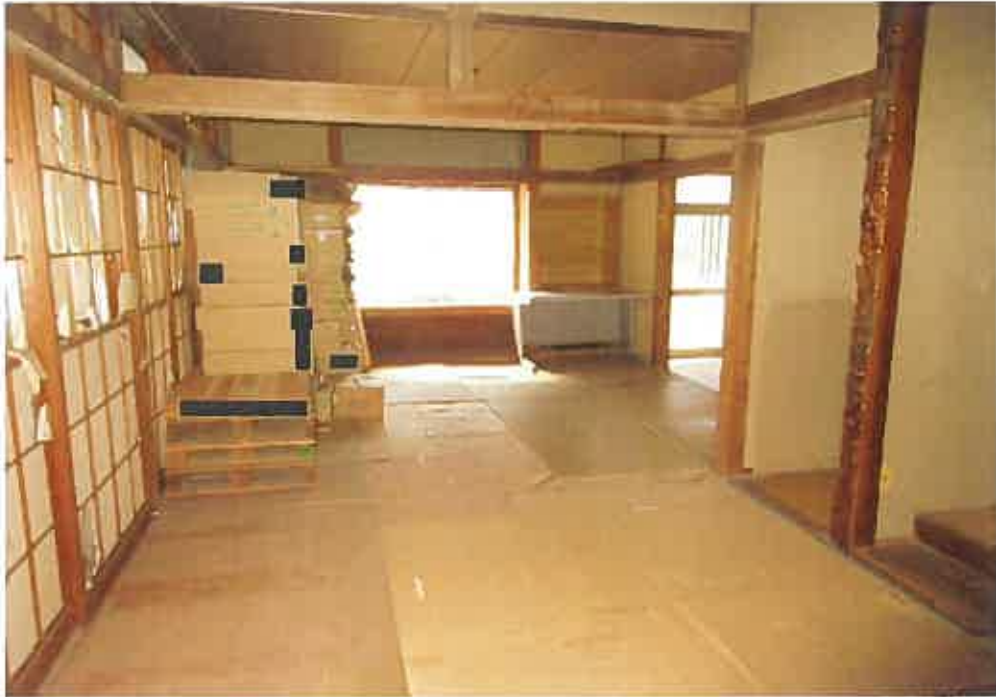
物件7:1階和室2間の状況
