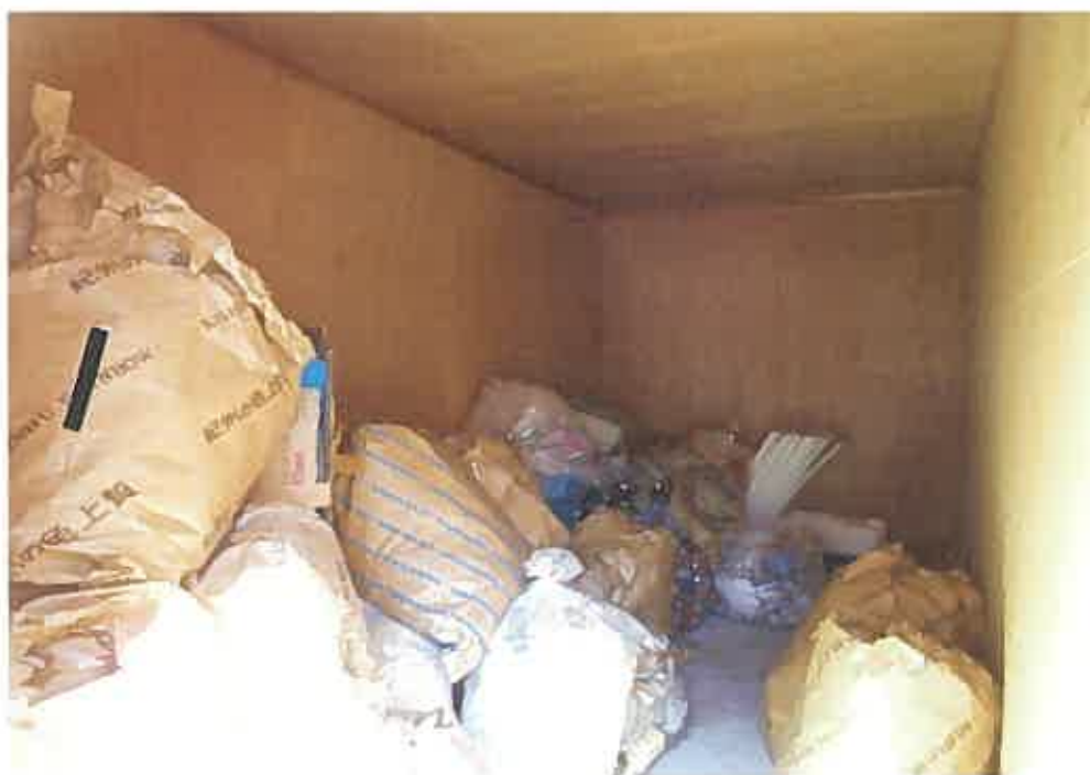
物件2未登記附属建物:北側倉庫部分の状況
