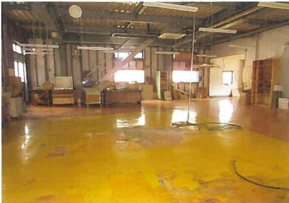
物件2主である建物: 1階工場の状況
