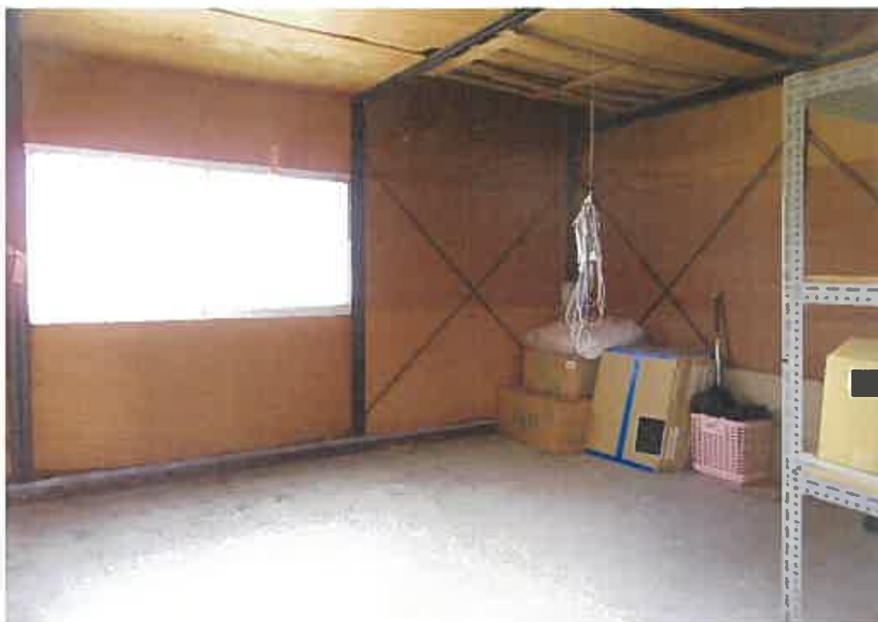
物件2未登記附属建物:南側倉庫部分の状況
