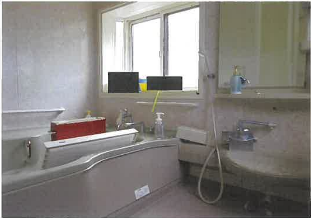
物件2:1階浴室の状況
