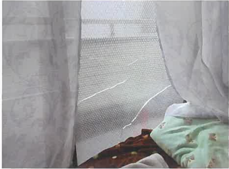
物件3:2階南東側洋室のサッシの亀裂
