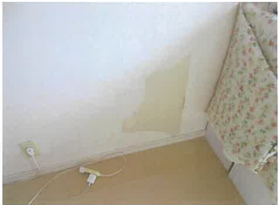
物件3:2階南西側洋室の壁クロスの剥離
