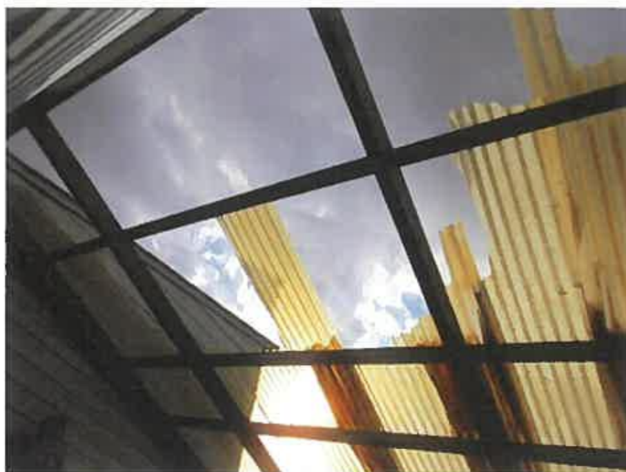
物件1:3階ベランダ天井の毀損状況
