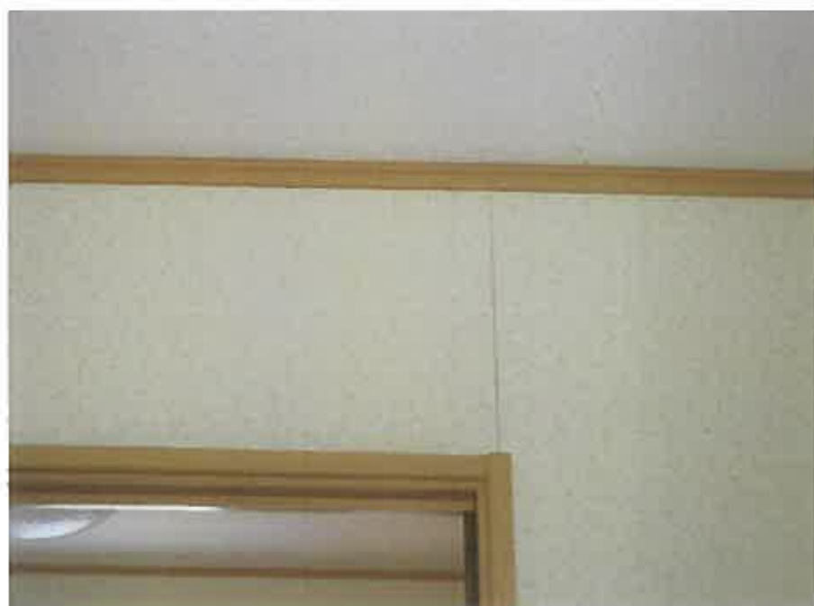
物件3:2階南西側洋間壁面の亀裂
