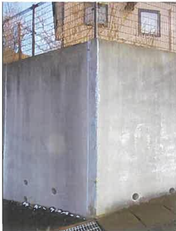
物件1:土留め部分の亀裂(修繕済み)
