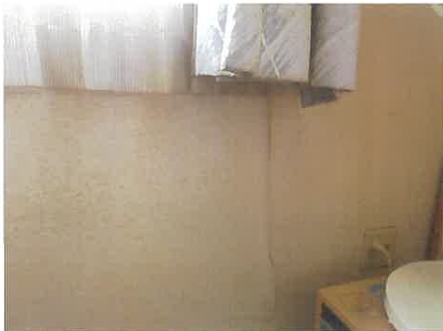
物件1:3階南西側洋室の壁クロスの亀裂
