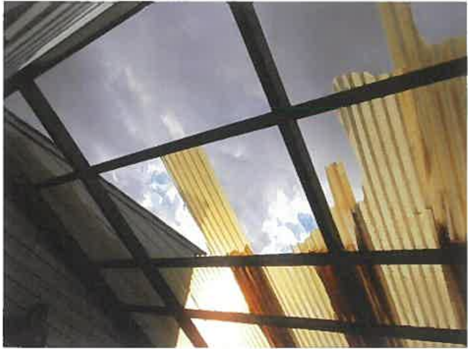
物件1:3階ベランダ天井の毀損状況
