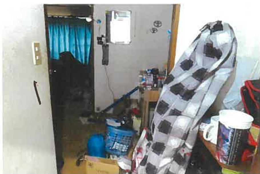
物件9主である建物:2階206号室の台所の状況
