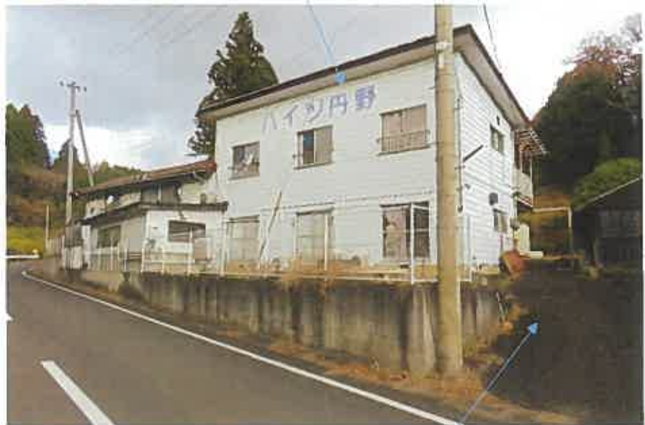
物件9主である建物
