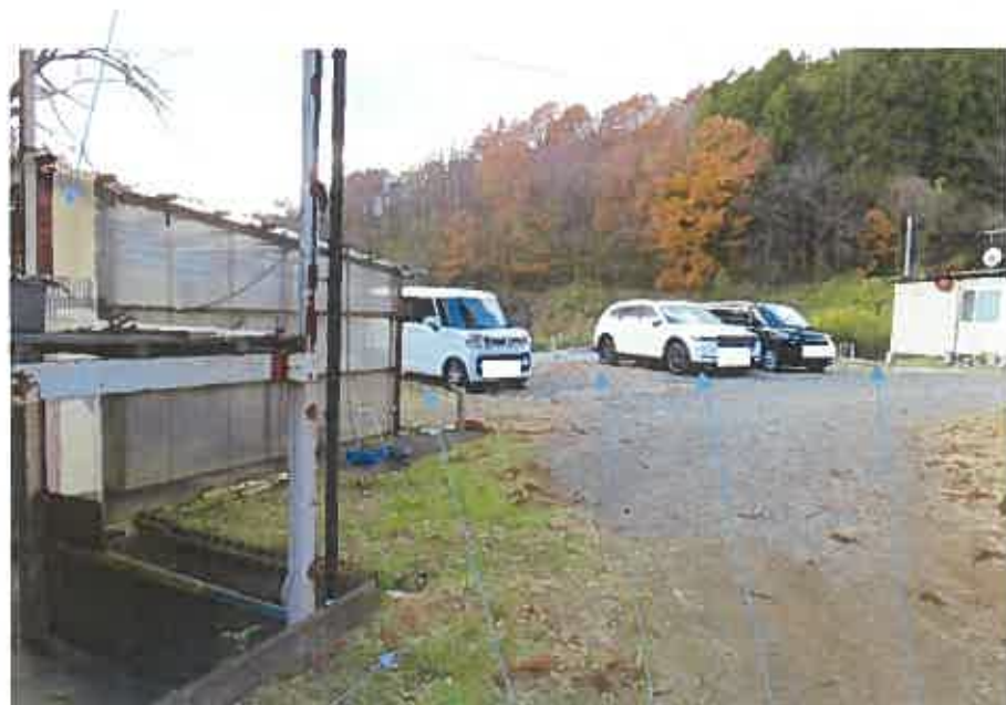
物件9主である建物
