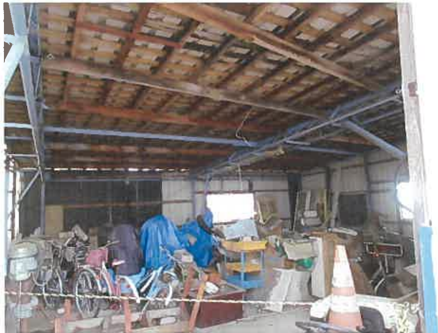
物件9未登記附属建物:内部の状況
