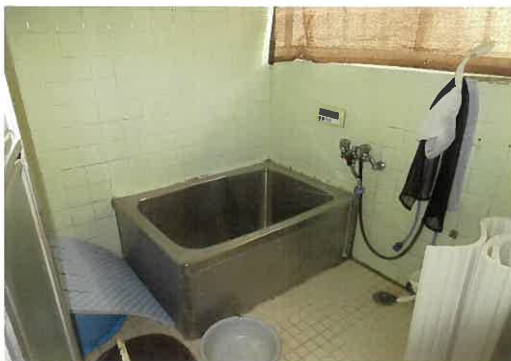
物件2主である建物: 1階浴室の状況
