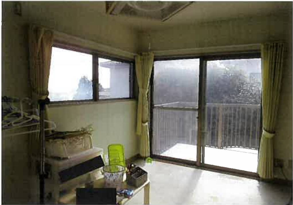
物件5:2階東側洋室の状況
