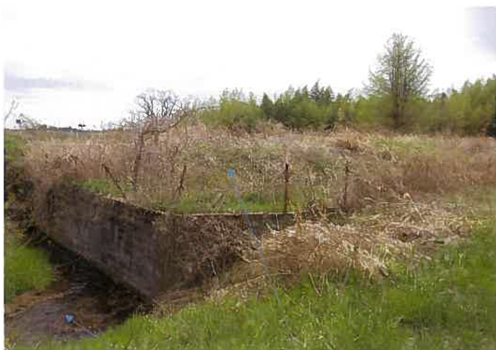
水路(山上字荒屋舗34番土地内)
