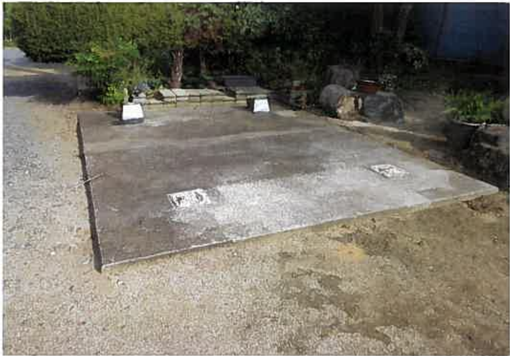
物件1コンクリートの土台の状況
