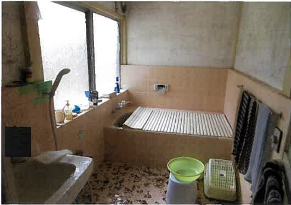
物件3主である建物:1階浴室の状況
