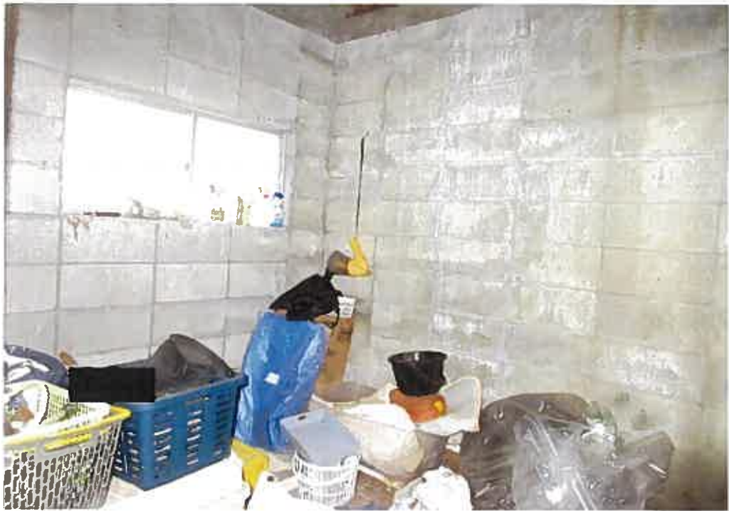
物件3附属建物:内部の状況
