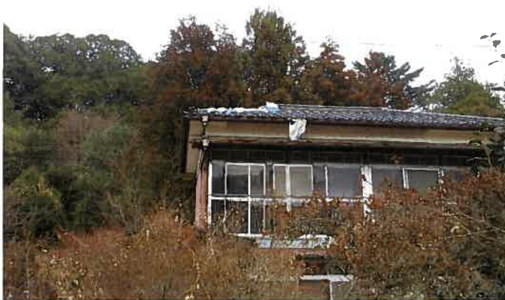
物件3主である建物の屋根の状況
