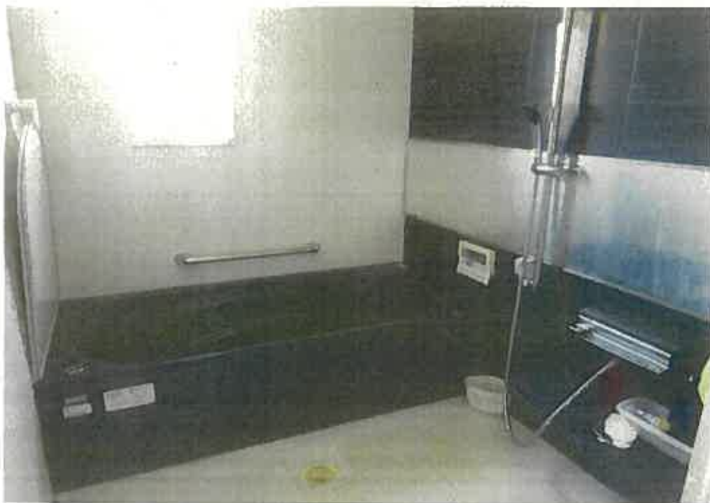
物件3:1階浴室の状況
