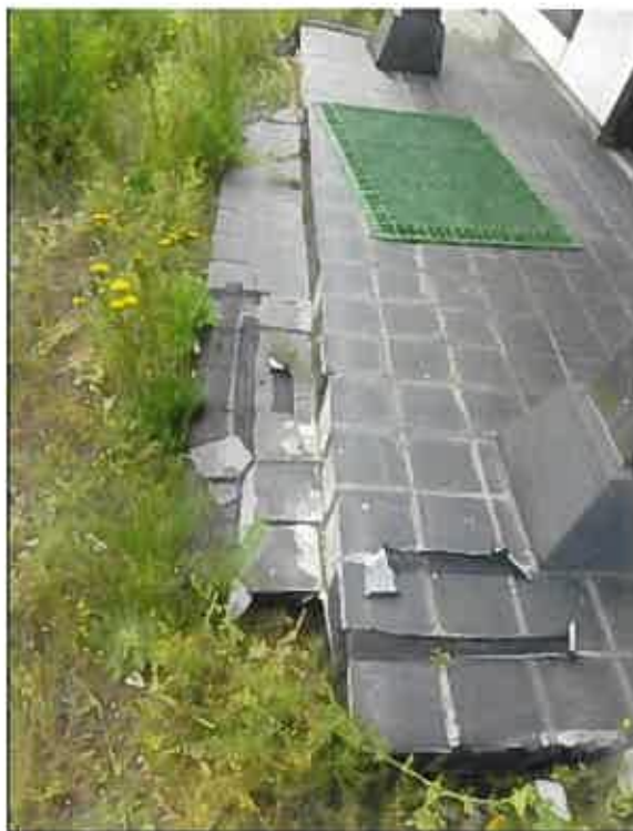
物件10:玄関前のタイルの破損状況
