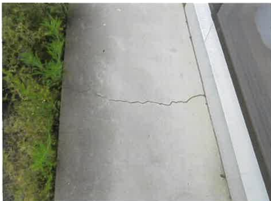
物件10:南側犬走り部分の亀裂
