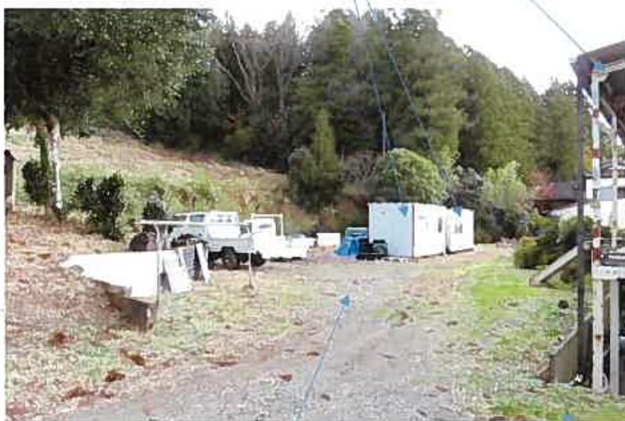
プレハブ物置 物件9主である建物
