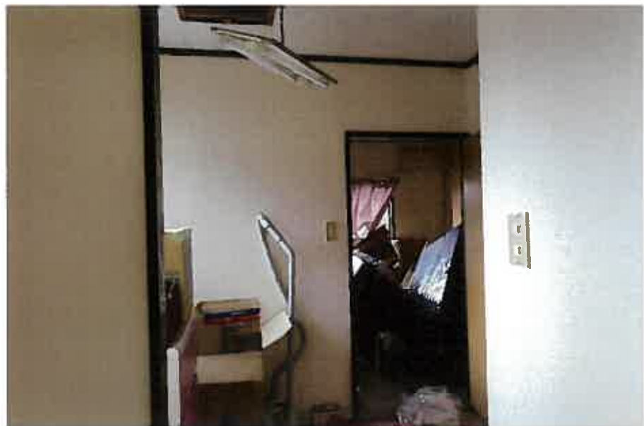
物件9主である建物:1階101号室の室内の状況
