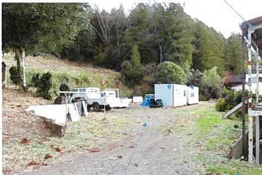
プレハブ物置 物件9主である建物
