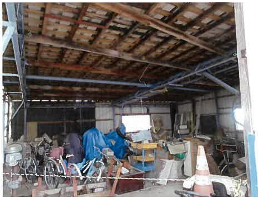
物件9未登記附属建物:内部の状況
