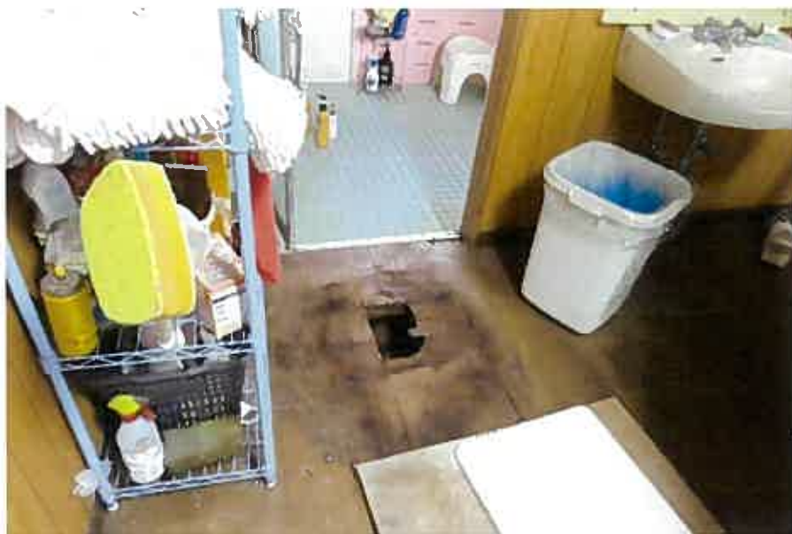
物件9主である建物: 1階106号室の洋室(脱衣所)の状況
