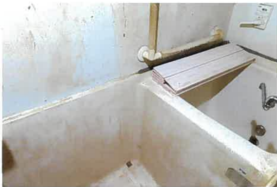
物件9主である建物:2階205号室の浴室の状況
