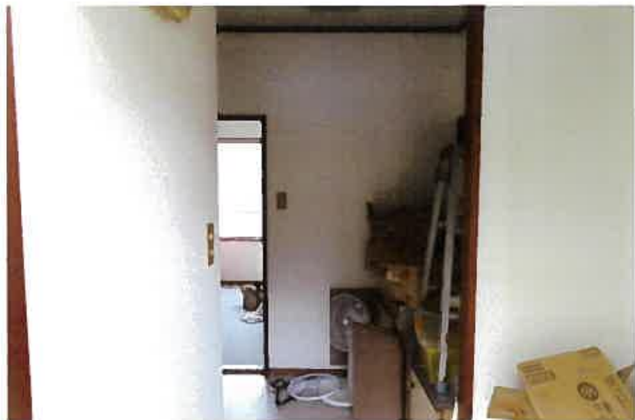
物件9主である建物:2階203号室の台所の状況
