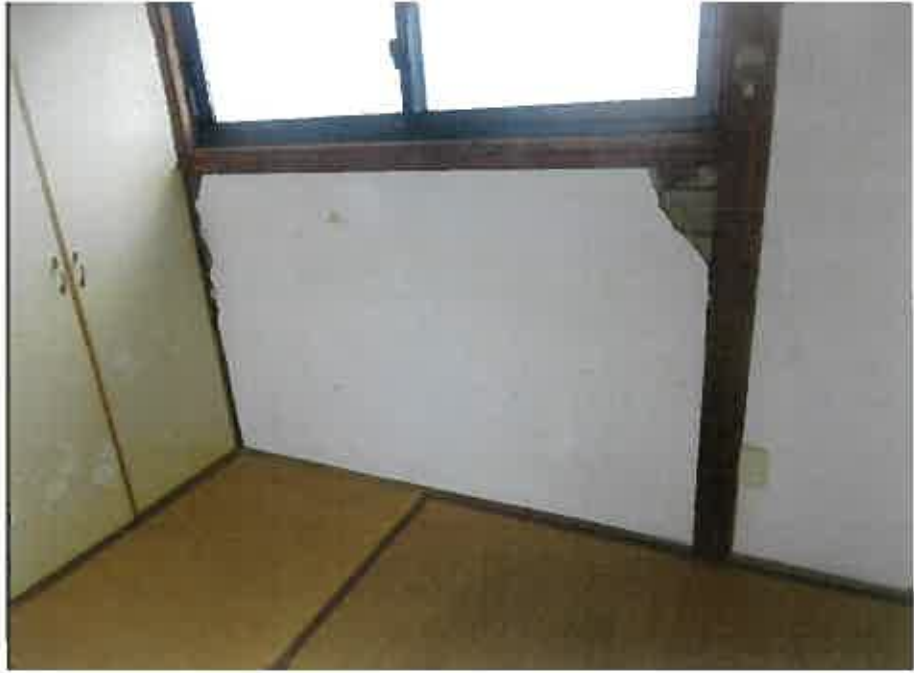
物件3: (主である建物の部分) 2階和室③の内壁の破損
