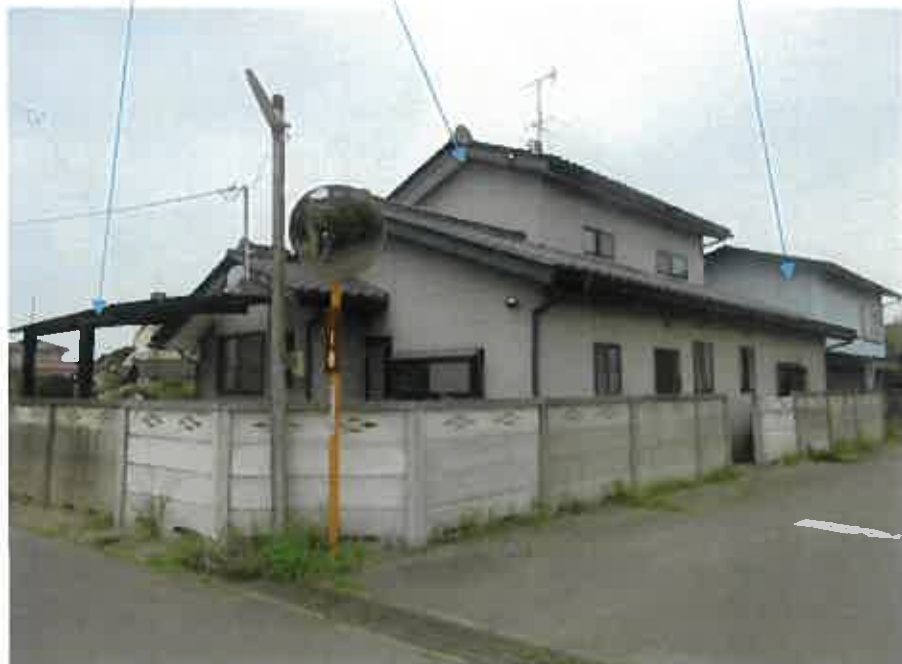
物件3(主である建物の部分)
