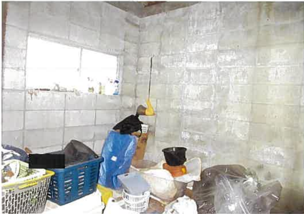
物件3附属建物:内部の状況
