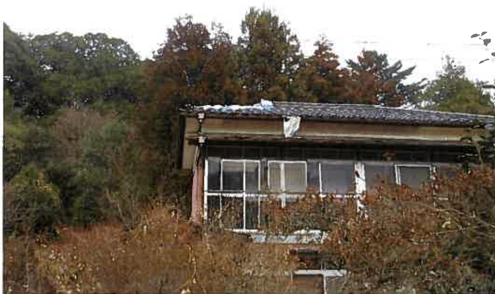
物件3主である建物の屋根の状況
