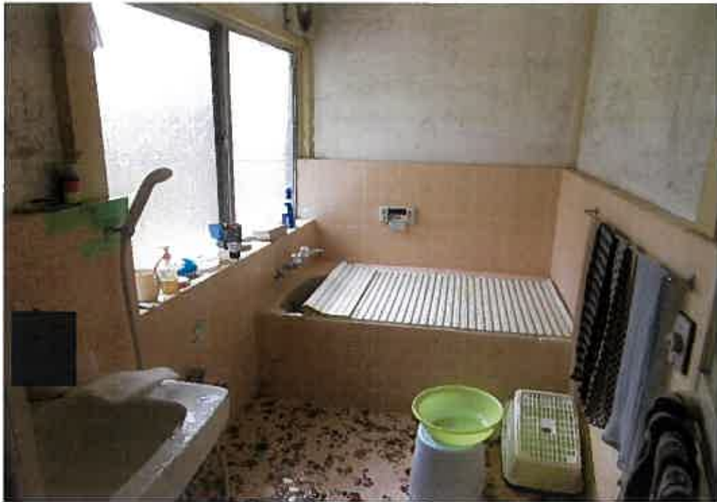
物件3主である建物:1階浴室の状況
