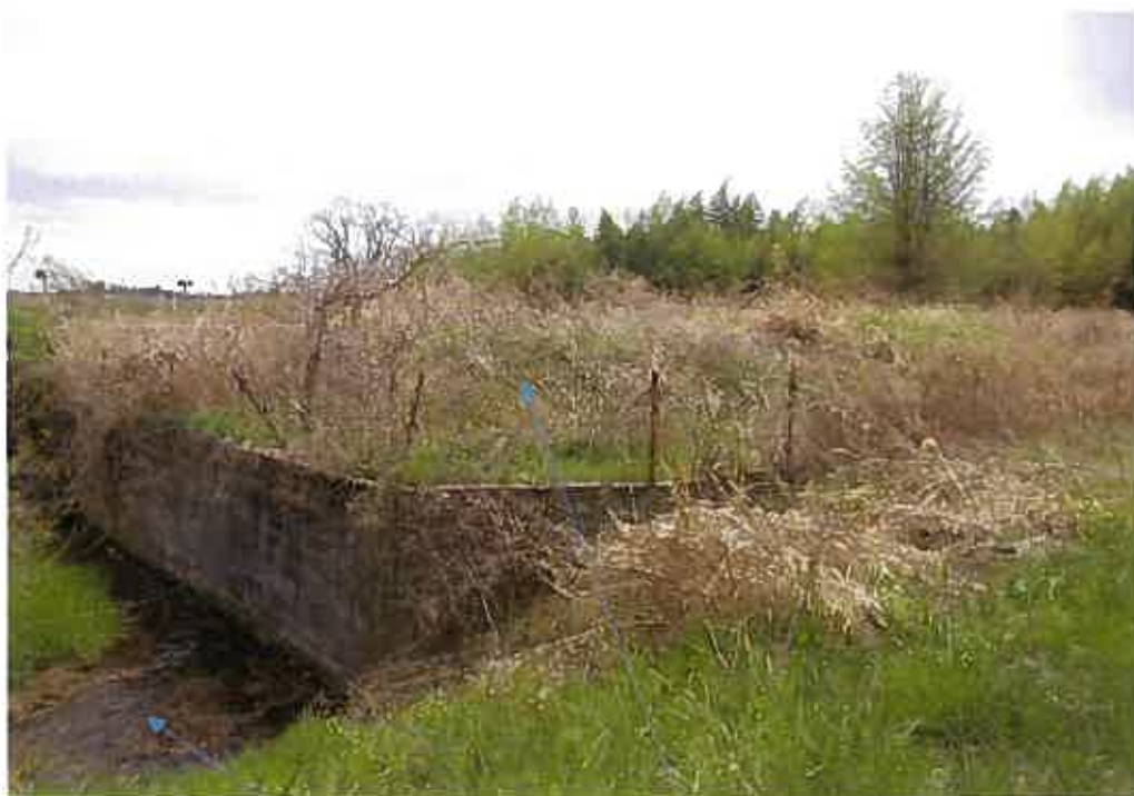
水路(山上字荒屋舗34番土地内)
